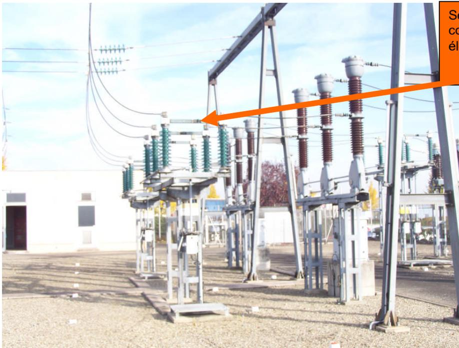
Sectionneur assurant une coupure visible du circuit électrique
