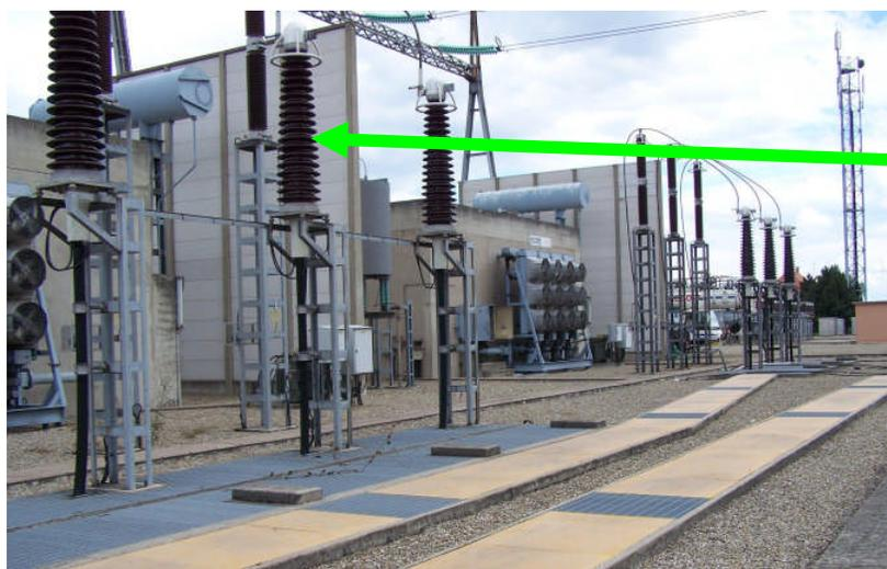
Disjoncteur 63 kV, protège les circuits et les installations contre les surcharges
