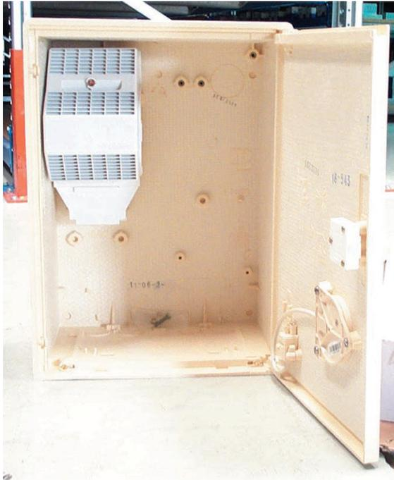
Le coupe-circuit est installé de façon à être accessible depuis le domaine public et reçoit des fusibles ou des barrettes de taille 2 (115mm).
